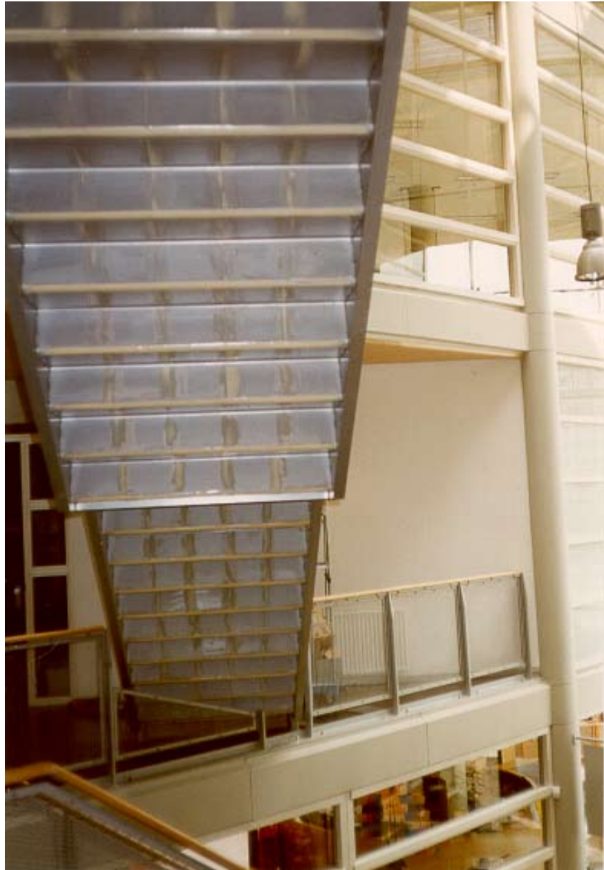
Vibradamp® 1K toegepast op een stalen trap
